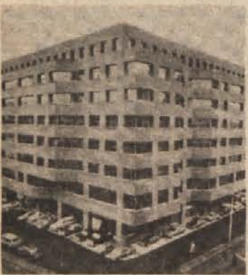
Samoogrevalna zgradba v Bostonu. Okna so pomaknjena navznoter, zidovi so debeli in dobro izolirani, šipe prevlečene, streha preprežena s cevmi.
