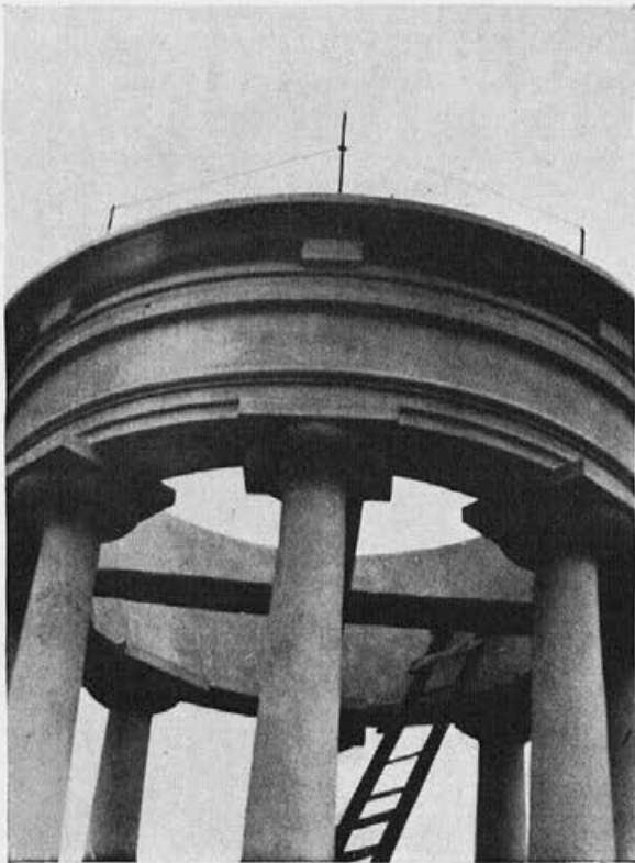
Instalacija strelovodov na nebotičniku
