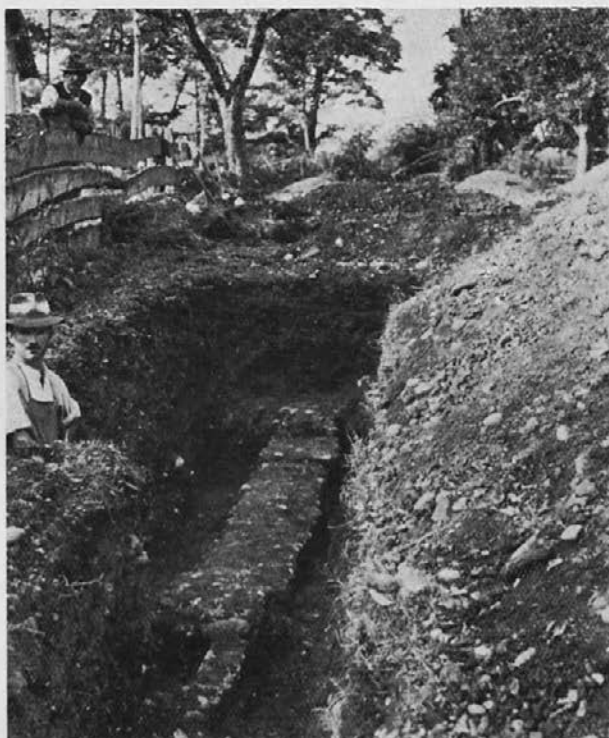
Sl. 29. Prag v zapornem zidu ob zahodni strani fora.
