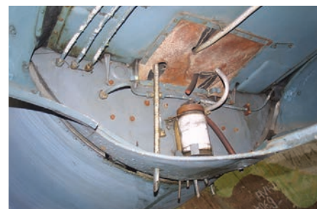
Pogled v notranjost kolesnih prostorov priča, da gre za en skupen kolesni prostor. Za sprednjo požarno steno je vidna dobro ohranjena in nepoškodovana usnjena manšeta, ki preprečuje dostop umazaniji v notranjost letala. (Foto: Tomaž Perme)
