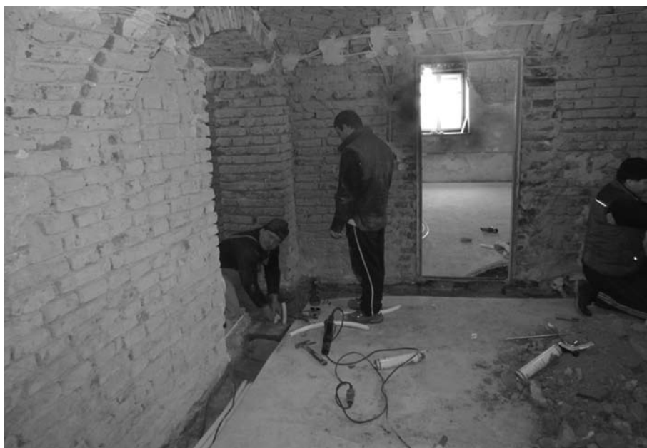
Polaganje centralne napeljave
