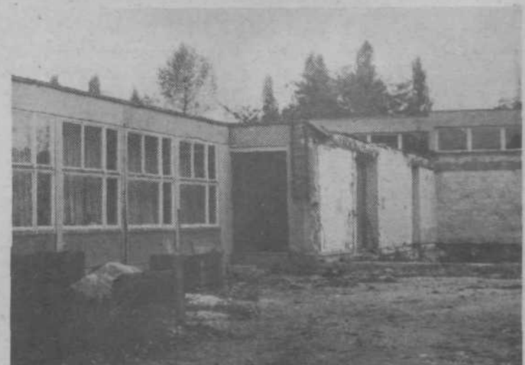
SANIRANJE VVZ ANGELCE OCEPEK - Najbolj poškodovani del stavbe je porušen - to je prva faza sanacijskih del na poškodovanem poslopiju vrtca Angelce Ocepek. V drugi fazi bodo popravili poškodovani obstoječi del stavbe z okrepitvijo temeljev, sten, centralnih sanitarij, inštalacij itd. Ta dela bodo končana do konca leta. Za tretjo fazo je v načrtu gradnja novega dela stavbe, ki je sedaj porušena. Pričetek del bo mogoč, ko bodo zagotovljena sredstva. Od 800 starih milijonov, kolikor bo stala celotna sanacija, manjka še 150 starih milijonov. (Foto: S. G.)
