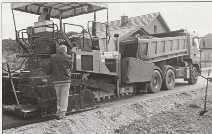
Asfaltiranje ceste v novem delu naselja Tržec
