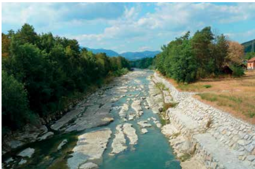
Slika 17: Povsem obzidana struga Savinje pod mostom ceste Parižlje–Polzela. Fotografirano ob suši avgusta 2013. Vidi se pospešena erozija v morsko sivico na rečnem dnu.
