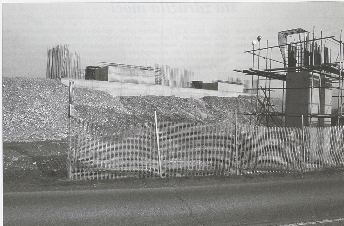
Pogled na delovišče na Zg. Hajdini, nedaleč od železniške proge, kjer je že vse nared za izgradnjo nadvoza.
