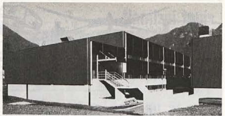
Tolminci so upravičeno lahko ponosni na šolski center. Na sliki: pogled na telovadnico.
