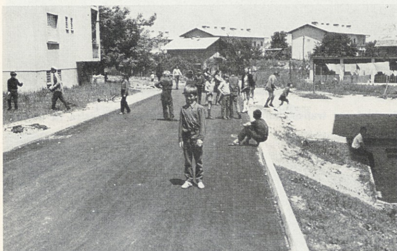
Na novo asfaltirane ceste so postale igrišče za otroke iz dida
