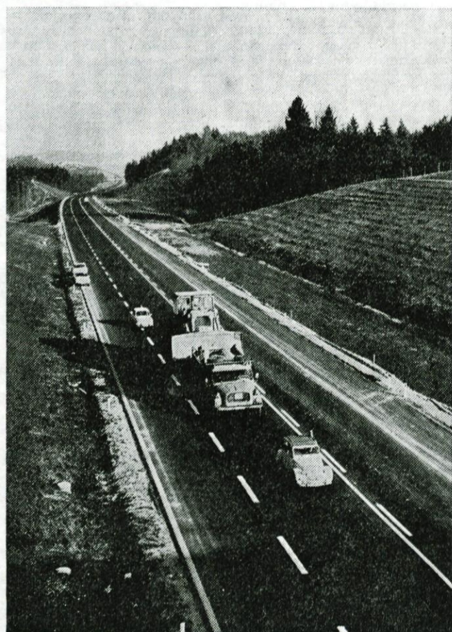
3 — SGP »SLOVENIJA CESTE« — TOZD Nizke gradnje Ljubljana je gradil 34,5 km dolg odsek avtoceste Hoče—Dramlje. Pogled na traso v useku Vrhole — v smeri Slovenske Bistrice. Foto: Strnad P.
