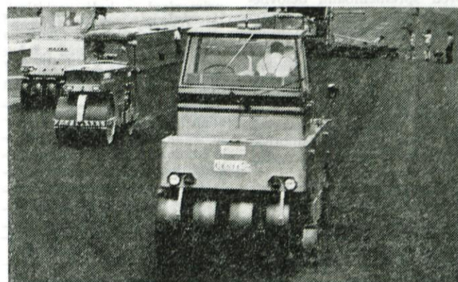
5 — V soboto, 29. maja 1976, je bila svečana otvoritev mariborskega letališča. SGP »SLOVENIJA CESTE«, TOZD Nizke gradnje je izvajalo vse objekte nizke gradnje kompletno z asfaltiranjem 2500 m dolge vzletne steze. Za Brnikom, Splitom, Zadrom, Pulo je to že peto letališče, ki ga je gradilo to podjetje. Foto: Strnad P.
