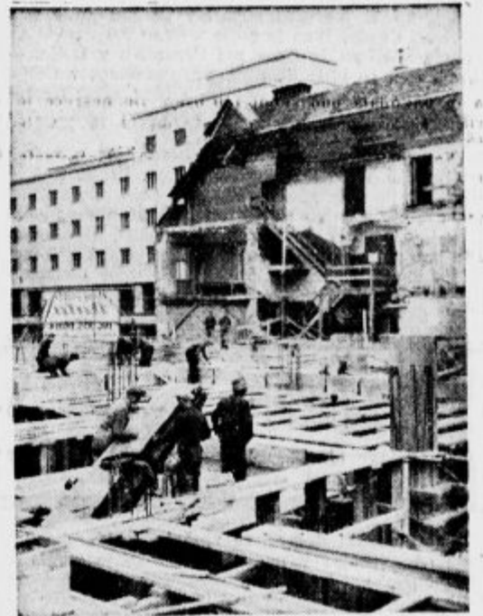
Pogled na leseni oder za strop pritličja Batove palače v Ljubljani. V ozadju je videti skoraj na polovico odsekano staro hišo Jadranske banke, ki stoji še ob Selenburgovi ulici in katero bodo po zgraditvi palače podrli. V ospredju stoji transportni trak, ki je vozil betonsko mešanico iz pritličja v prvo nadstropje.
