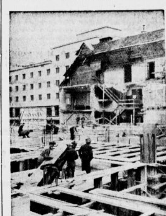
Pogled na leseni oder za strop pritličja Batove palače v Ljubljani. V ozadju je videti skoraj na polovico odsekano staro hišo Jadranske banke, ki stoji še ob Selenburgovi ulici in katero bodo po zgraditvi palače podrlí. V ospredju stoji transportni trak, ki je vozil betonsko mešanico iz pritličja v prvo nadstropje.
