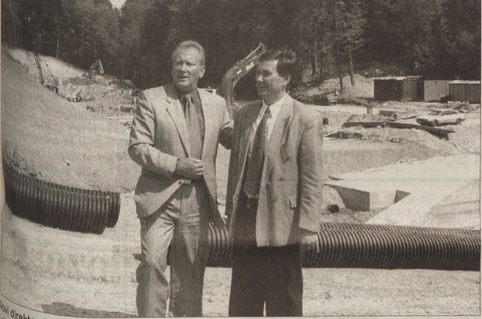
Novi direktor Slovenskih železnic mag. Igor Zajec z ekipo si je minuli teden ogledal gradbišče nove železniške proge med Puconci in Hodošem. Na posnetku z Markom Brezigarjem, vodjem projekta izgradnje nove proge, na pripravi predseka pred predorom med Mačkovci in Stanjevci
