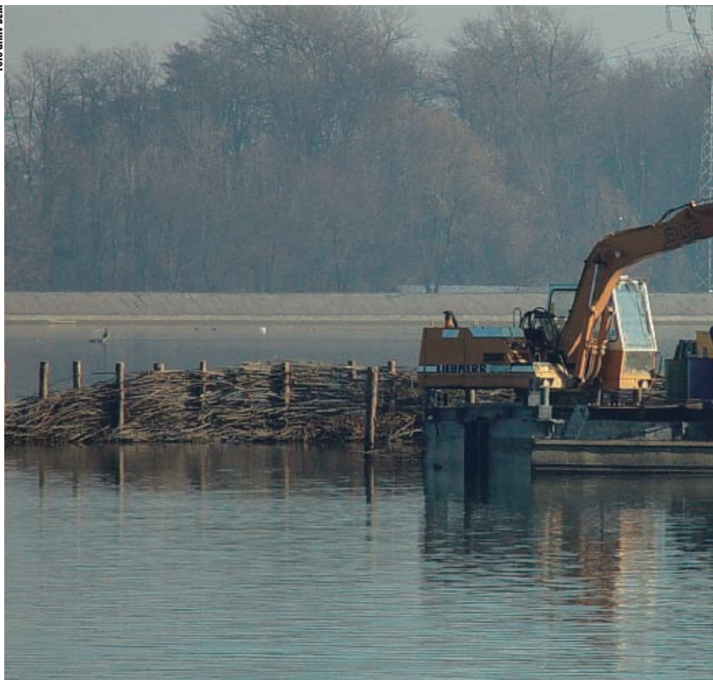
Za zgraditev umetnega otoka so morali nasuti kar 1900 m 3 mulja.
