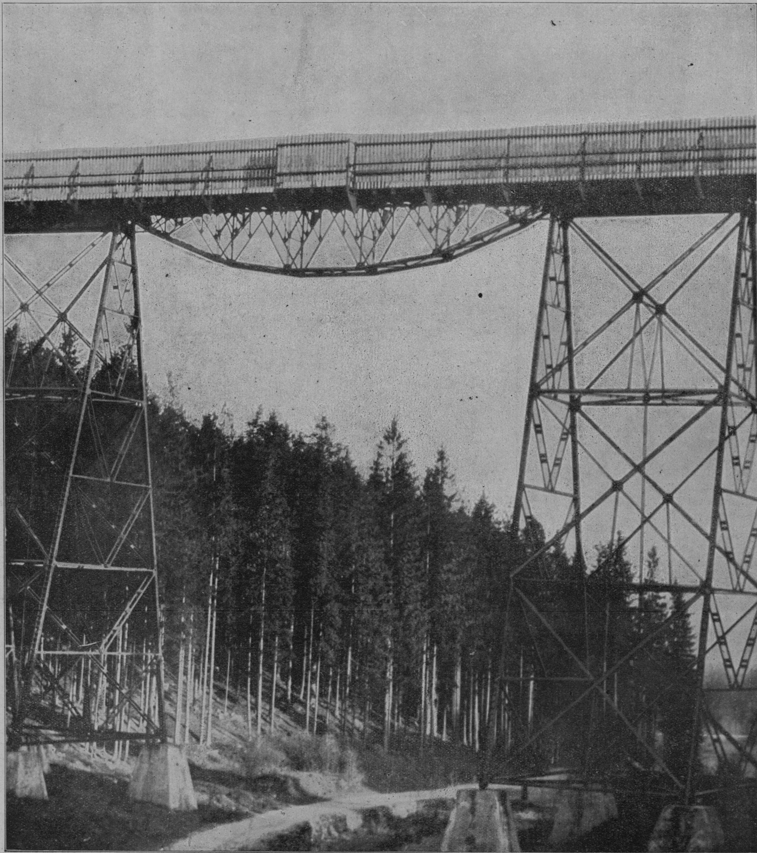
Tehniška umetnost: Most čez dolino pri Greifenbachu na Saškem. Most je iz samih železnih vezi na betonskih ležiščih ter 186 m dolg in 135 \frac{1}{2} m visok.
