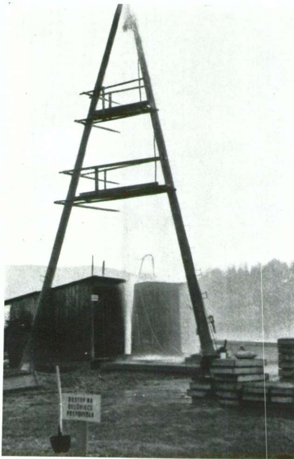
1. sl. Vrtina E-6 v zahodnem delu šaleške kadunje je zadela na arteško vodo
