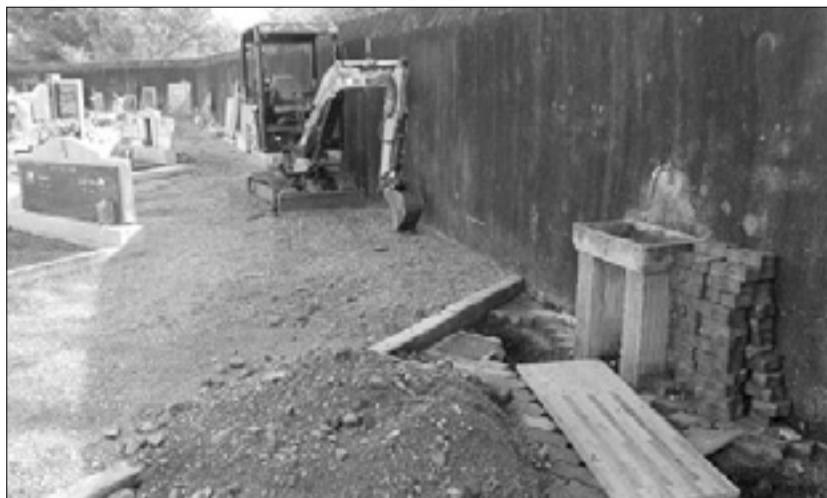
Na sovodenskem pokopališču so gradbena dela v polnem teku
