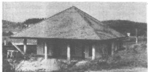
Gradnja dveh mrljiških vezič v Velikih Laščah poteka že šest let. Pravijo, da tako dolgo predvsem zaradi prezahtevnih in predragih načrtov. Gradbeni in pokopališki odbora pri krajevni skupnosti pa zdaj nadaljujeta z deli interne povezave s pokopališčem in ureditvijo okolice, kjer pa se urejajo tudi nekatere premoženjsko pravne težave.
