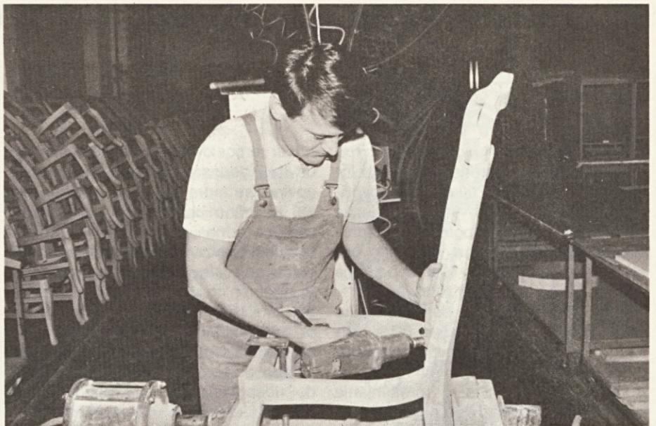
Posnetek je iz PE-8 in prikazuje sestavljanje zahtevnega stola na klasičen način, z matičnimi lesnimi vijaki.
