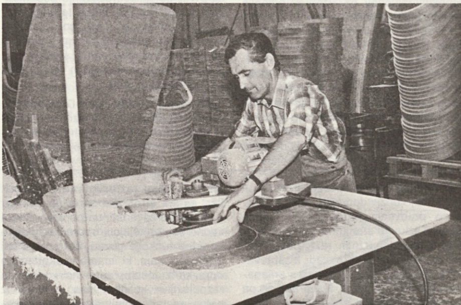
Na tej sliki vidimo naslednjo operacijo. Avtor inovacije je isti. Krivina ima zarezkano pot točne debeline, po kateri bo tekel rezkarjev obroček. S podajalno napravo je delo hitro, varno in točno.
