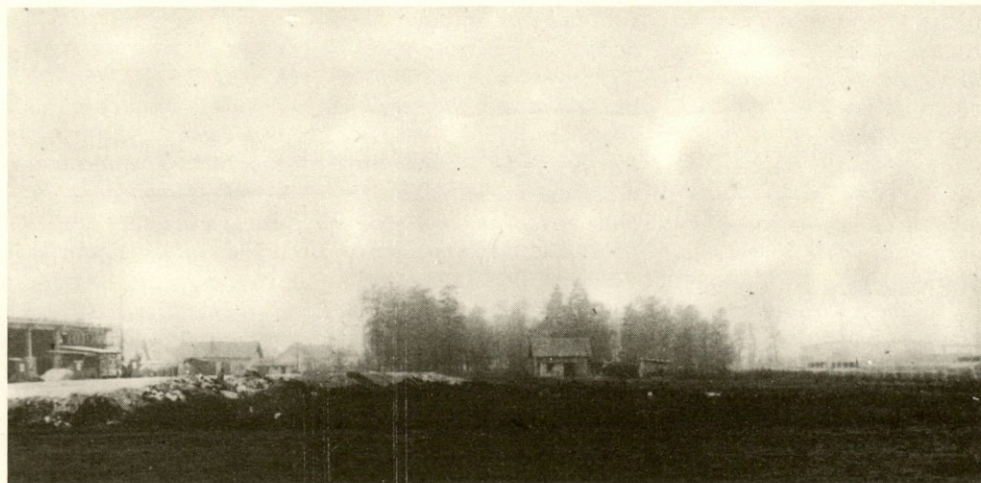
Prostor namenjen izgradnji terminala za pripravo metalurškega vložka. Levo naše novo celjsko skladišče v izgradnji.
