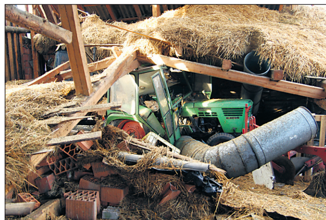
Foto: M. Ozmec Porušena gospodarska poslopja so pod seboj uničevala tudi kmetijske stroje in mehanizacijo.
