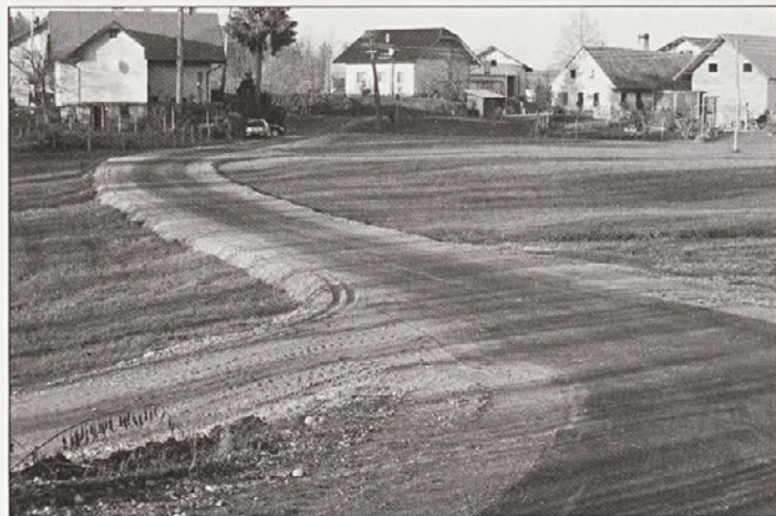
Pogled iz popovškega mostu na novo asfaltno cesto Pogled iz popovškega mostu na novo asfaltno cesto
