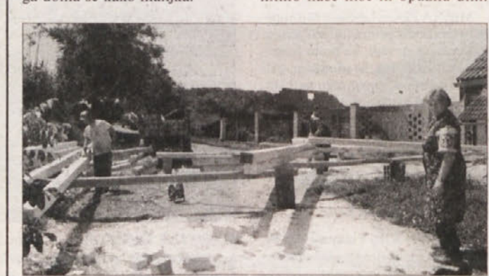
PRIPRAVA NOVEGA OSTREŠJA - Genovefa Kotar (na desni) je žalostno pokazala na pogorišče zadaj, pri hiši pa so te dni že delavci, ki pripravljajo novo ostrejšje. (Foto: L. M.)
