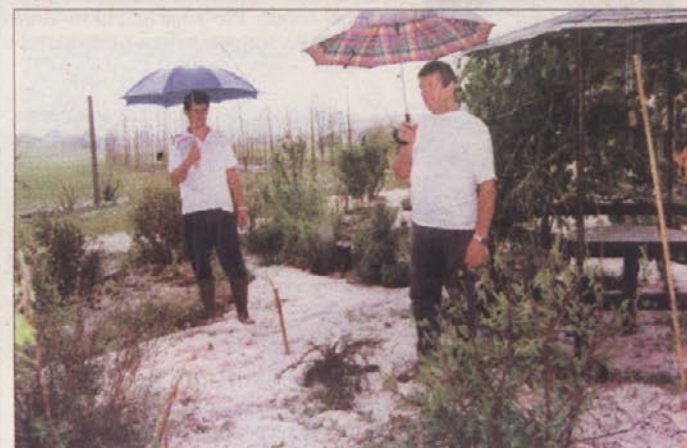
PO TOČI - Neurje s točo se je v nedeljo zneslo tudi nad Stražo pri Sentrupertu, od koder je posnetek. Vihar je razkrival strehe in lomil dreve. Na sliki: Ciril Bevc (desni) in sin Tomaž na domačem dvorišču, nekaj zatem, ko sta pokrila streho gospodarskega poslopja. (Foto: M. L.)
