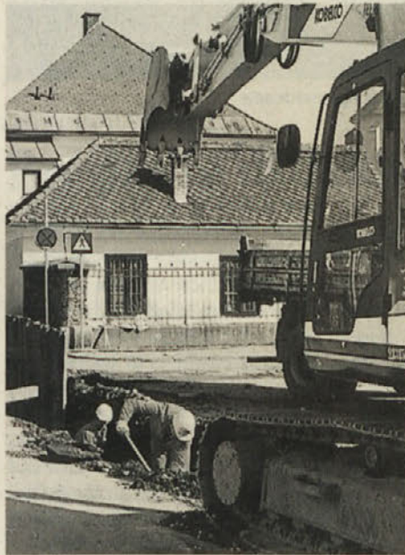
Gradnje kanalizacij zagotavljajo tisoče delovnih mest
