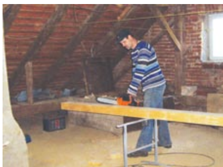
Obnova stropa – Blaž
