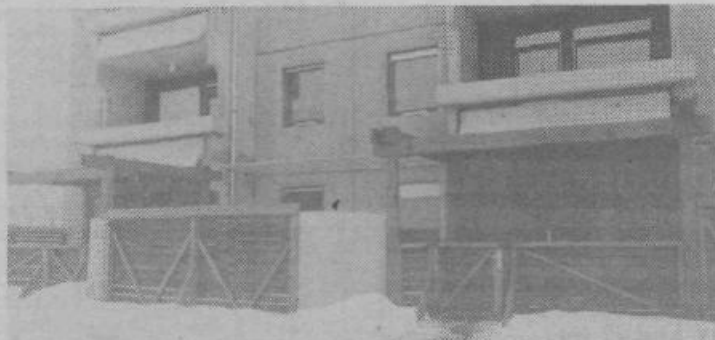
V enoti vrtca Angele Ocepek na Leninovem trgu 14 ima vsaka skupina otrok (tako kot v objektu A-24 na Leninovem trgu 9) svoj vhod. Vsaka skupina ima tudi svojo garderobo in sanitarije; razdelilna kuhinja je skupna. Prostori vrtca so popolnoma ločeni od stanovanjskih prostorov v stolpnici — prednost takega načina gradnje vrtca pa je tudi ta, da bo kasneje brez velikih težav te prostore mogoče preurediti v stanovanja. — (Foto: D. J.)
