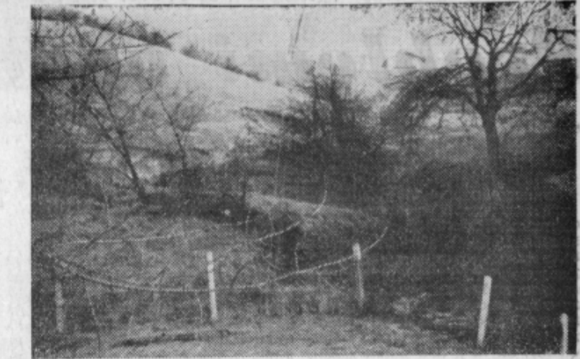
ZE NEKAJ LET OPAZUJEJO STANOVALCI ALJAZEVEGA HRIBA PLAZ, KI ZLAGOMA A VZTRAJNO LEZE Z VRHA PROTI ZADNjemu DELU TOVARNE TOPER. PO MERITVAH GEODETSKEGA ZAVODA JE DoločENO, DA BO SANACIJSKA DELA SPOMLADI OPRAVILO KOMUNALNO PODJETJE ZA CESTE IN KANALIZACIJE, ZANIMIVO PA JE, DA TOVARNA NE MISLI PRISPEVATI DENARJA, CETUDI JE NEPOSREDNO NJEJ V KORIST, DA BI PLAZ ZAVAROVALI. DENAR BO MORALA DATI OBČINSKA SKUPŠČINA CELJE.
