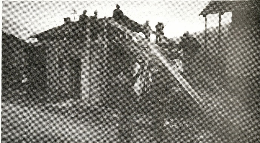
Gradnja novega doma je hitro napredovala
