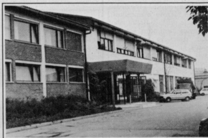
Nekdanje prostore Centrovoda ima sedaj v najemu dvajset manjših podjetij in tu bi lahko nastal obrtniško-poslovni center Lenarta.
