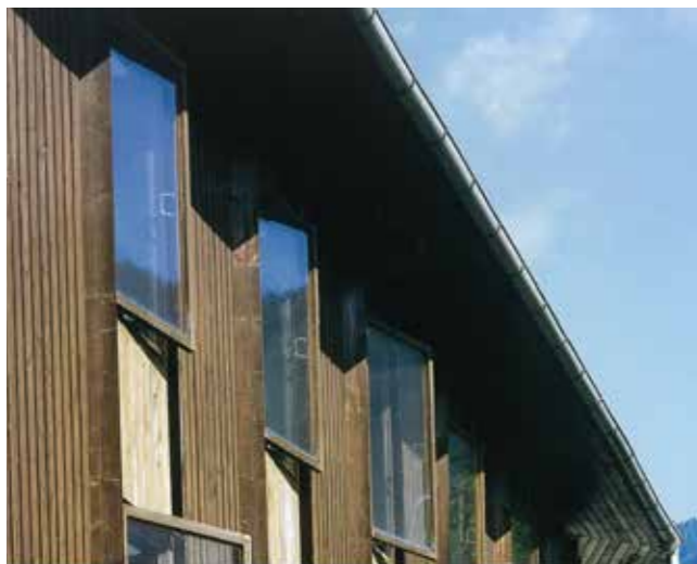
Slika 3: Še danes sodobna reliefna fasada z betonom in lesom.
