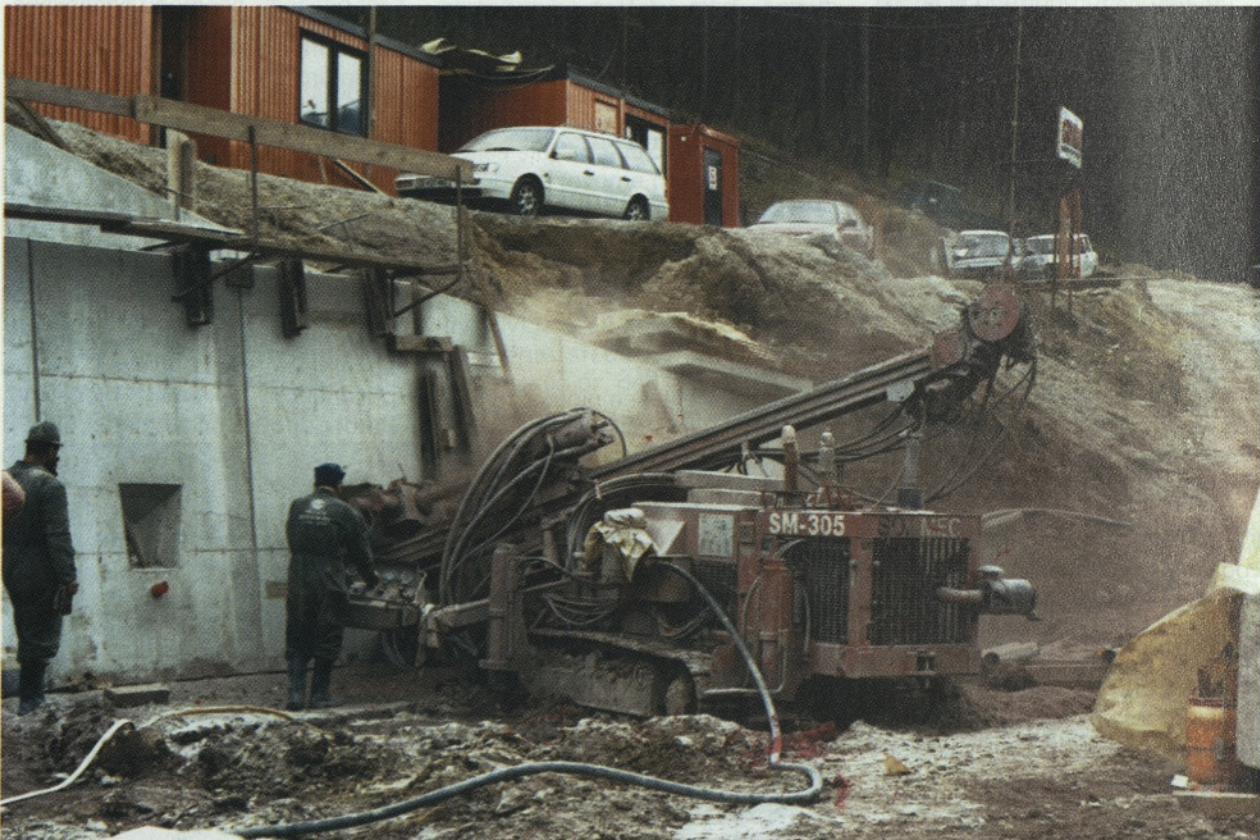
Slika 3: Trojane OZ 06: vrtanje vrtin za trajna geotehnična sidra
