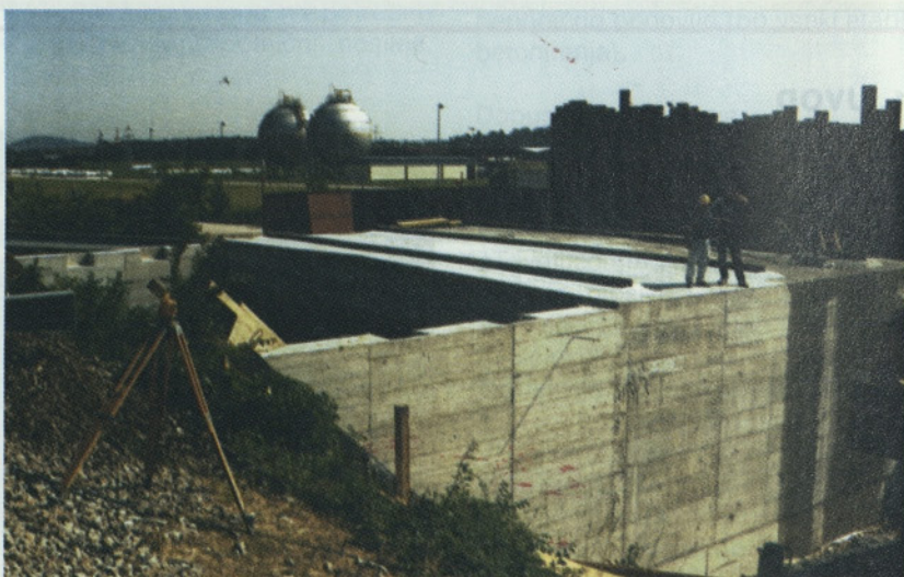
Slika 2: Že izvedena AB konstrukcija z začasnimi krilnimi zidovi z izpusti za montažo vzdolžnih IPB 600 nosilcev ter vidnimi IPB 140 jeklenimi nosilci - drsnimi pasovi na zgornji plošči
