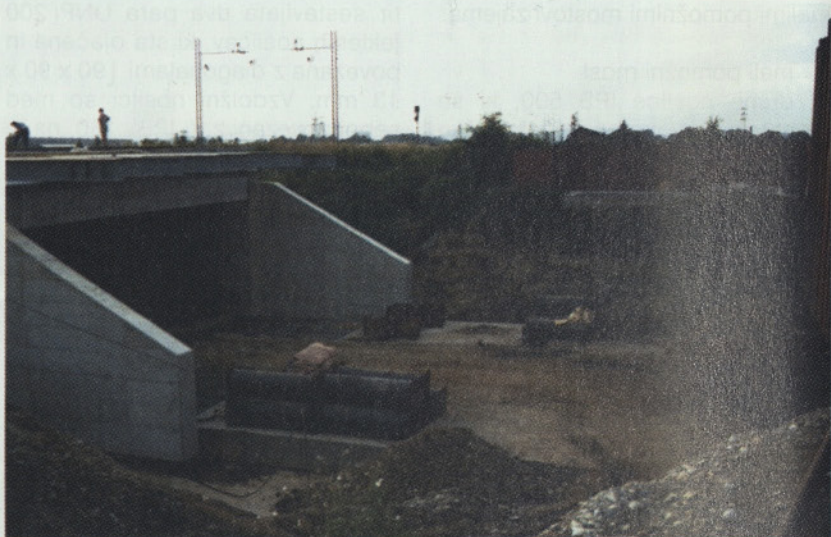
Slika 8: Druga faza vrivanja; po izvedbi AB razpornega bloka in kril objekta
