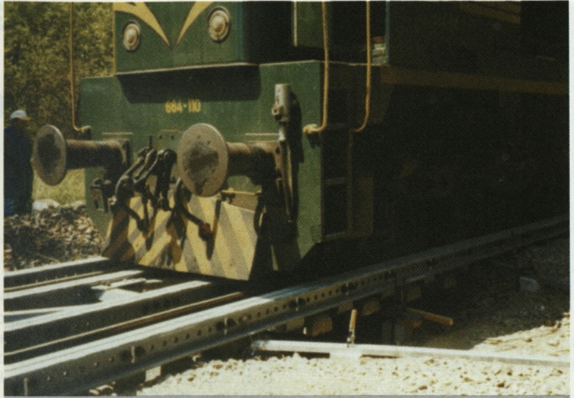
Slika 10: Obremenilna preizkušnja "malega pomožnega mostu"
