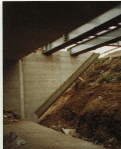
Slika 8: Naleganje drsnih nosilcev na jeklene nosilce na rezilih
