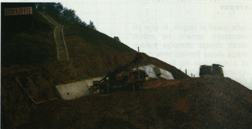
Slika 3: Vrtanje skozi obložno steno na I. etaži izkopa (GZL-Geoprojekt)
