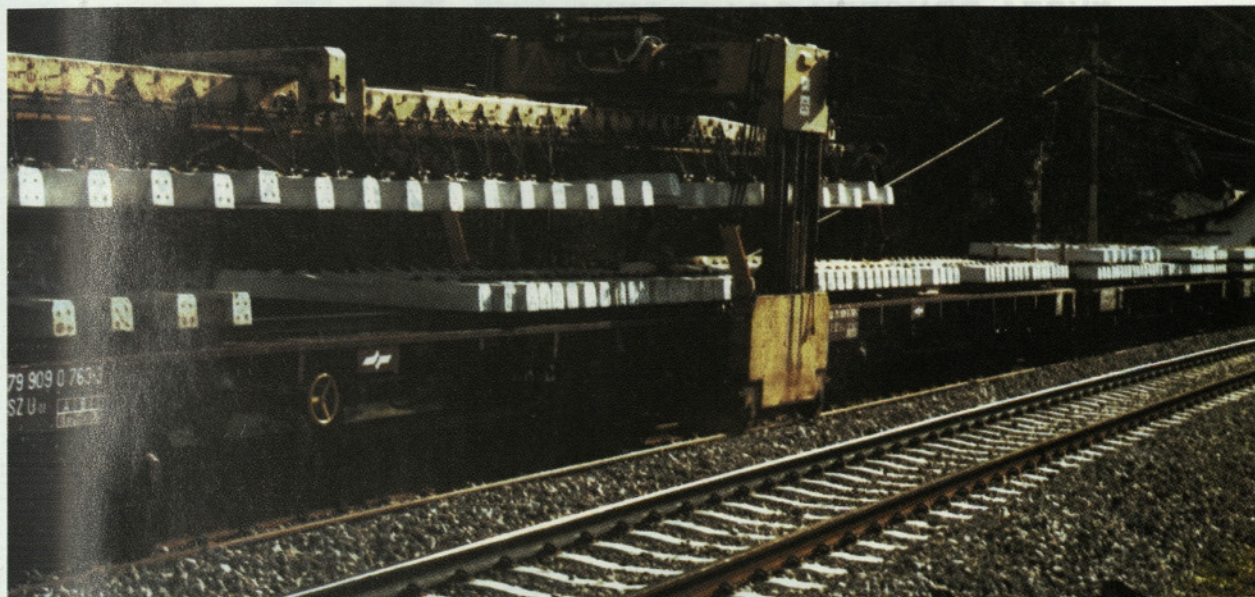
Slika 6: Strojno polaganje pragov v progo
