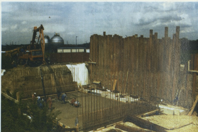
Slika 1: Betoniranje talne plošče mosta HC4 4, 5-12, v ozadju vidna oporna zagatna stenain oporni AB blok
