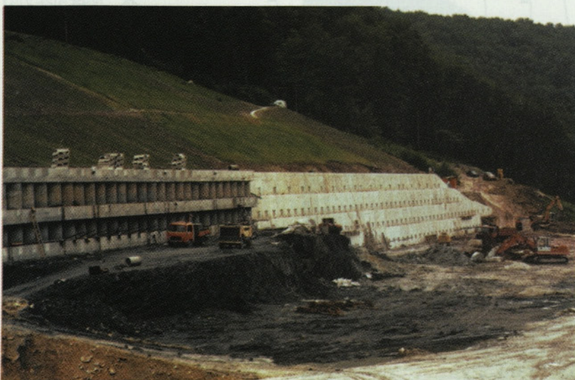
Slika 2: Oporni zid OZ 06 - pripravljala dela I. Trojane
