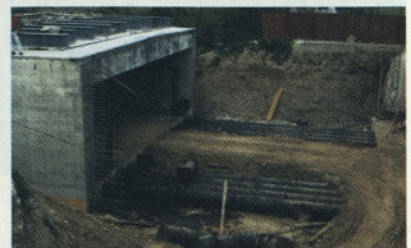
Slika 6 in 7: Z napredovanjem vrivanja objekta se večja število razpornih elementov
