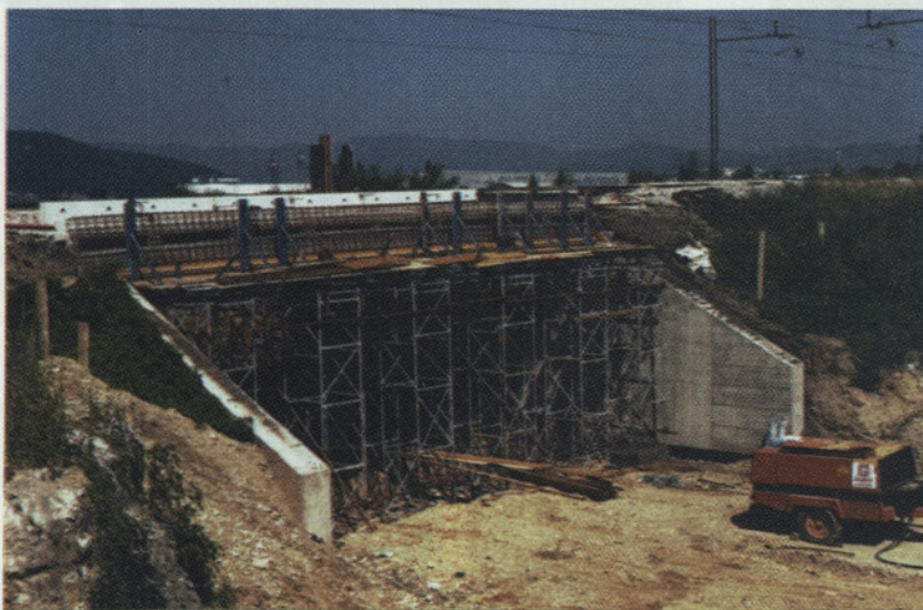
Slika 9: Finalizacija mostu HC 4, 5-12 - izvedba robnih vencev
