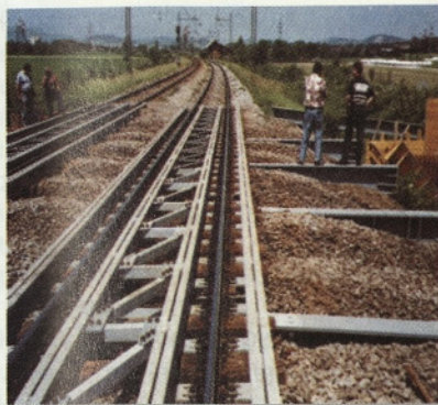
Slika 6: Mali pomožni most, nameščanje drsnih nosilcev
