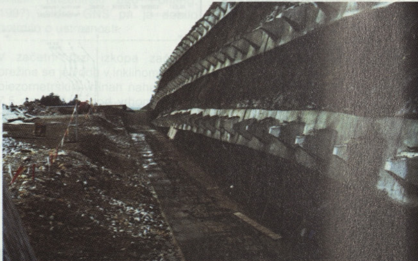
Slika 7: Dokončan delno zasut objekt in začasno odprta brežina, uspešno varovana s sidranimi obložnimi pasovi
