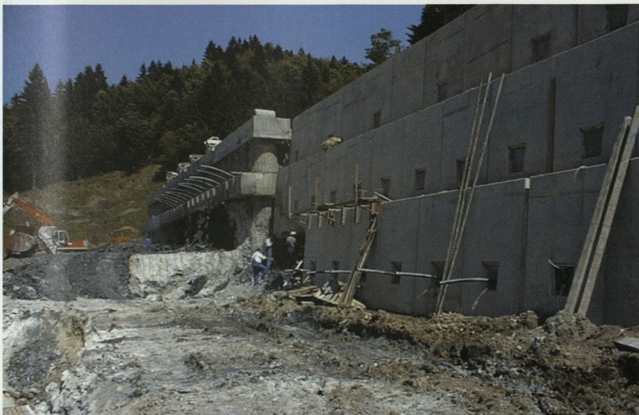
Slika 1: Posnetek narejen med izvajanjem zidu
