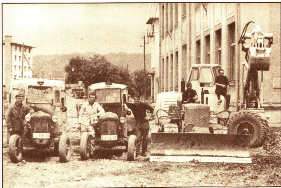
Začetek gradbenih del 2. junija 1964
