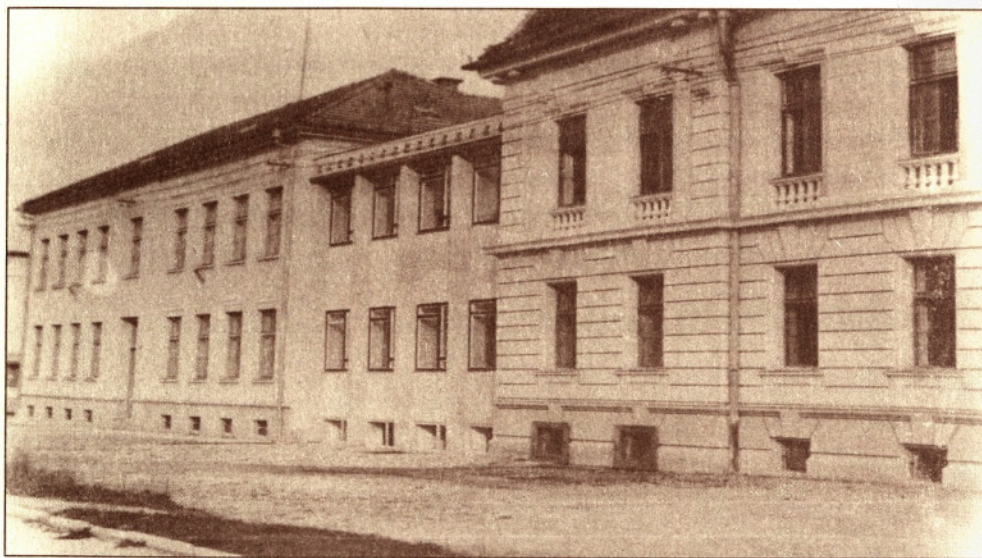
Vmesni prizidek je povezal obe šolski zgradbi.
