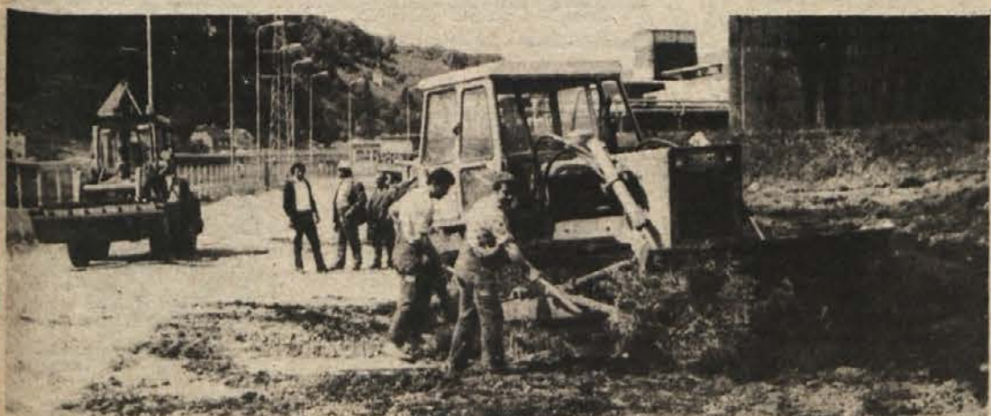
PRI CELULOZOJI ZABRNELI STROJI — Takoj po prvomajskih praznikih so pričeli delavci krškega Pionirja s širokimi odkopi za čistilne naprave na treh lokacijah. Zemeljska in gradbena dela bodo do decembra, ko bodo pričeli montirati čistilne naprave, v glavnem zaključena. Zaenkrat ni razlogov, da ne bi začele čistilne naprave po 15 mesecih tudi delovati. (Foto: P. Perc)
