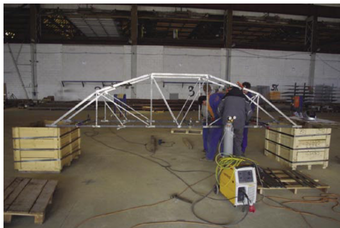
Slika 13 • Izdelava mosta v delavnici
