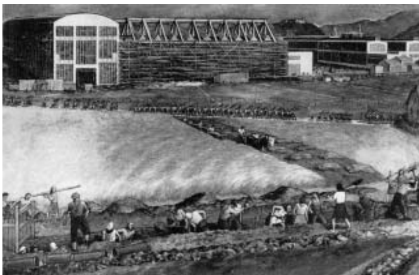
2. Tone Kralj, Gradnja Litostroja , 1948.
