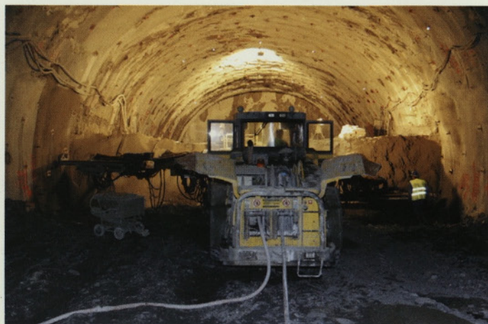
Slika 5 • Vgrajevanje sider v stopnici tripasovnega predora
