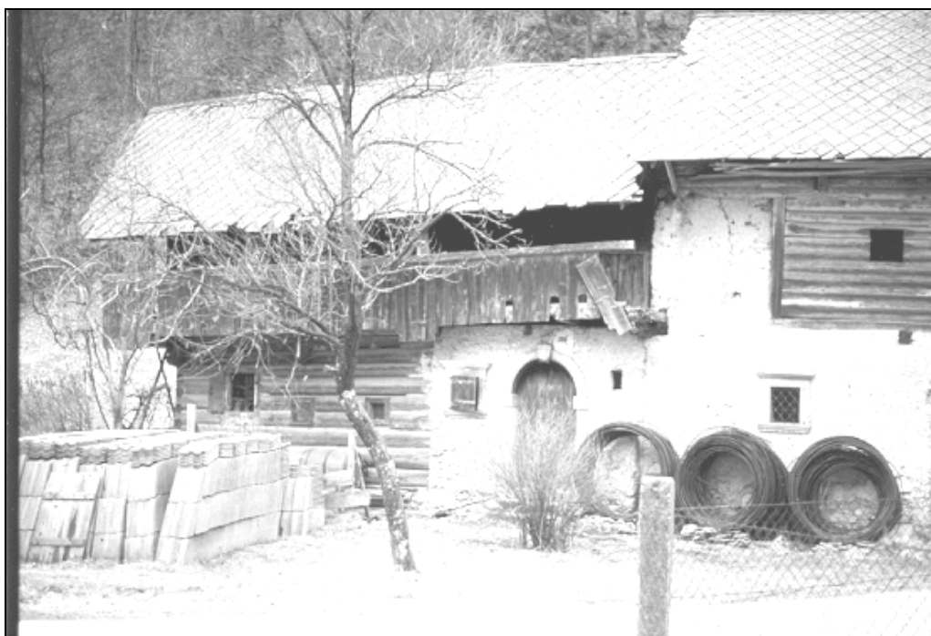
Grad pri Cerkljah št. 21, nadstropna hiša pred prezidavo leta 1991 (foto: Silvester Gaberšček)
