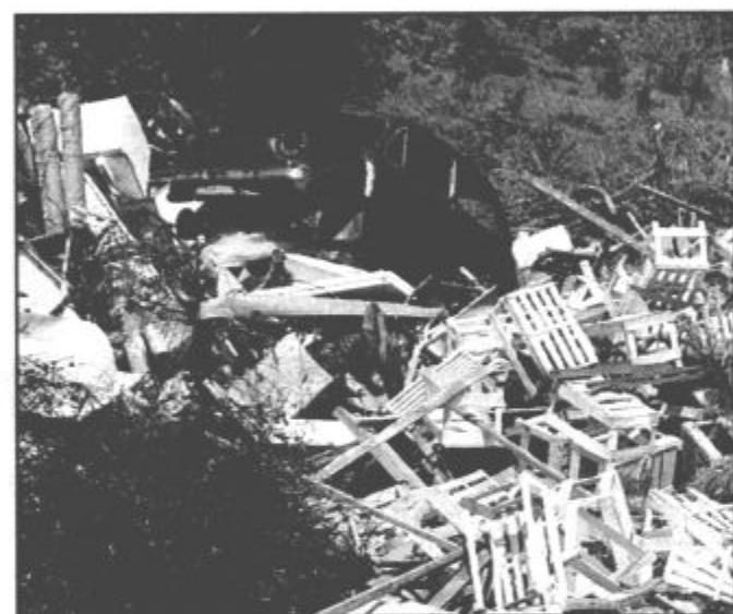
Primer enostavnega ekološkega dvorišča na centralni deponiji komunalnih odpadkov - kupa pločevine in lesnih odpadkov čakata na odvoz s posebnimi vozili. Pločevino bo vozilo najprej stisnilo in jo nato odložilo na Dinosu, zdrobljeni lesni odpadki pa običajno končajo na kompostarni. Slednji so primerni tudi za pokrivanje nabrežin in podobno.
