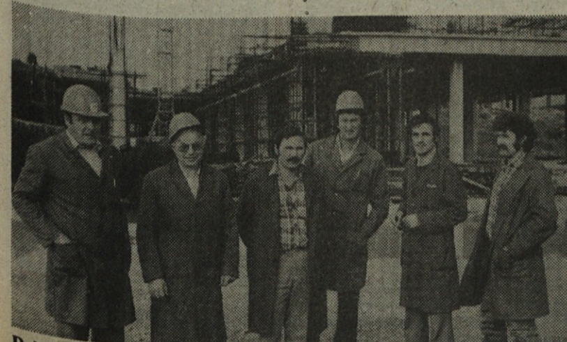
Del tehničnega kadra in delovodij na gradbišču, tehnik Ivo Peranec, vodja gradbišča inž. Franc Hočevnar, delovodje Tone Bokan, Štefan Šneberger, Ramiz Suljić in skladiščnik Ramo Horozović
