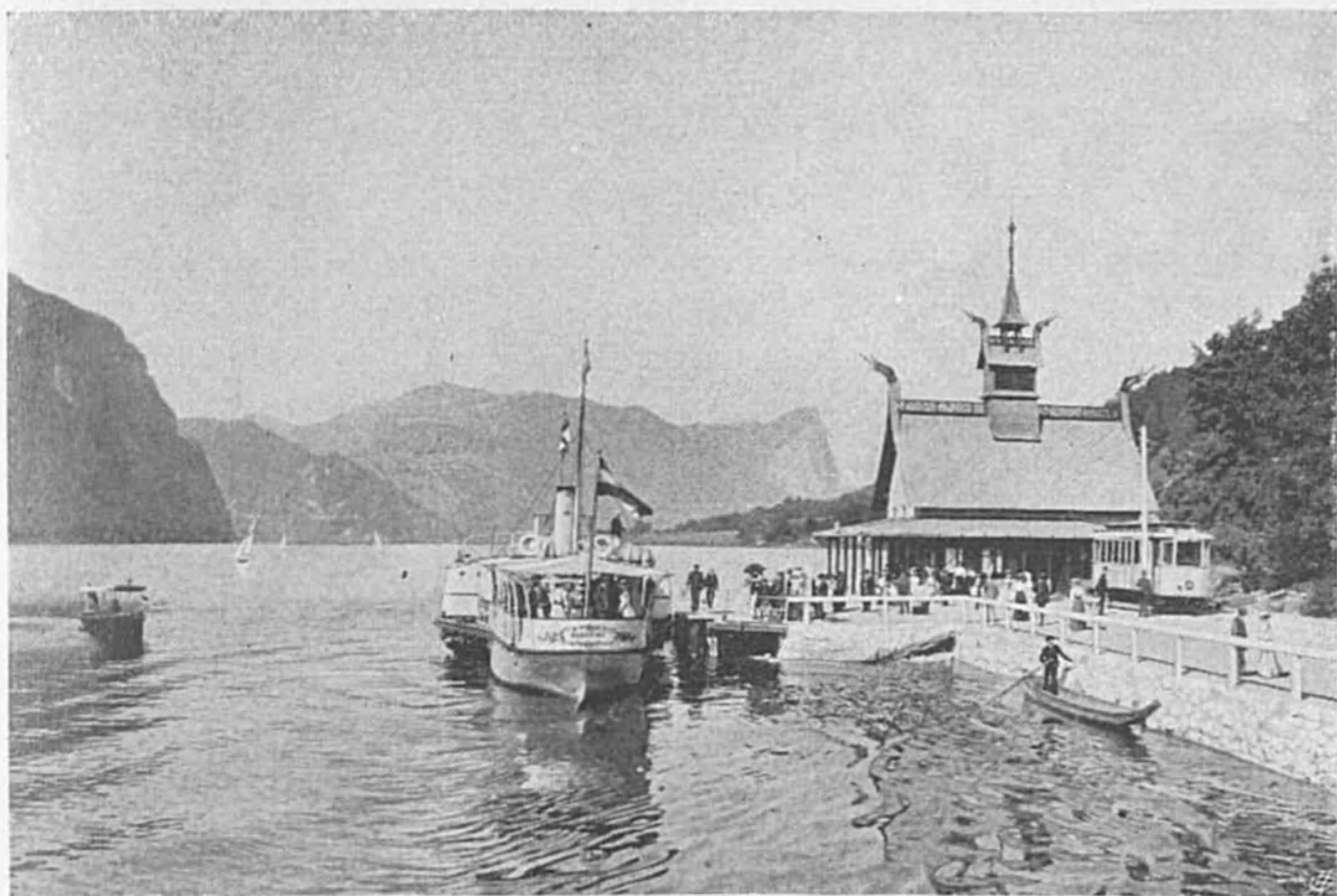
Pavillon der elektrischen Bahn in See
