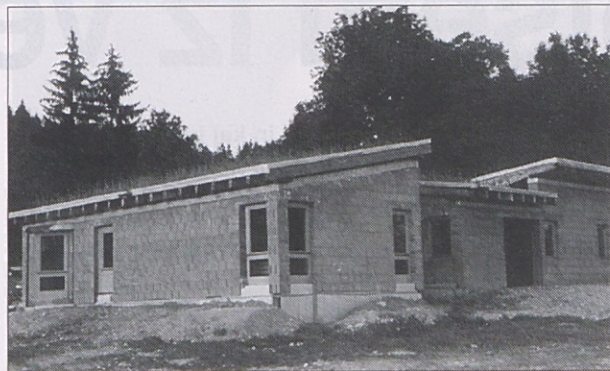
Travniške rože na strehi Mischkulnigove hiše
