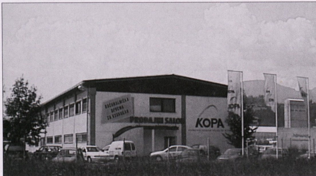
Poslovna stavba podjetja Kopa, d.d., s prodajalno v Slovenj Gradec
