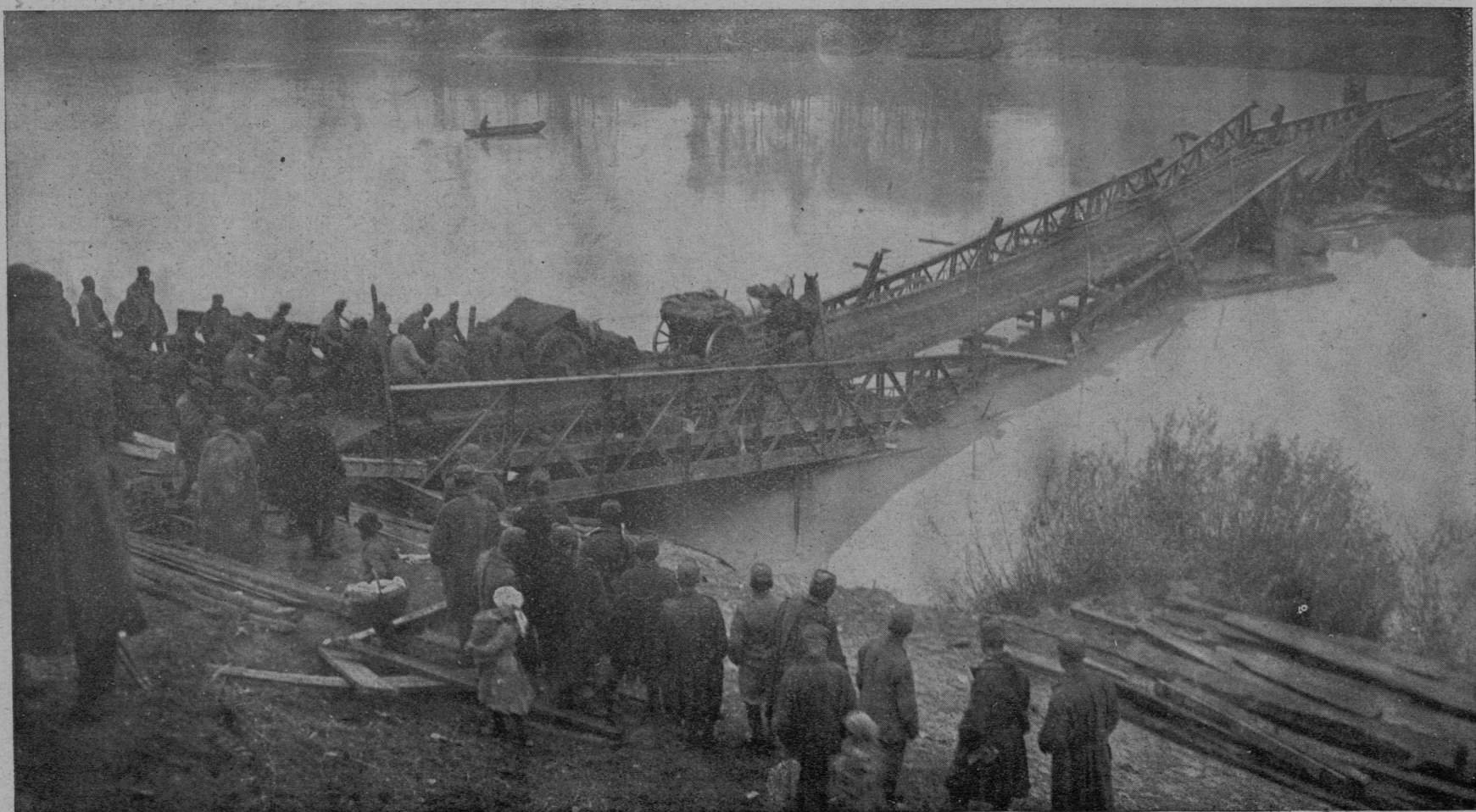
Naš tren vozi preko porušenega, le za silo popravljenega mostu preko reke Tilment.
