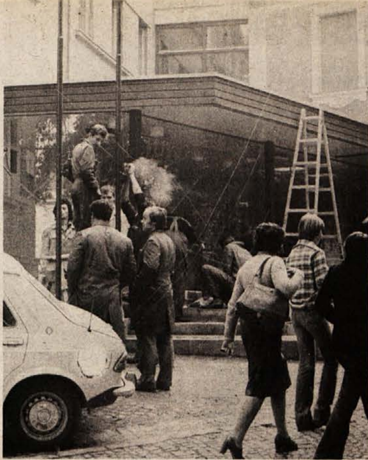
V ZADNJEM HIPU... Cela vrsta del je bila v Novem mestu opravljena šele takrat, ko so gostje že trkali na vrata. Prav v teh zadnjih trenutkih pa je bil marsikje postavljen rekord. V Metropoli (na sliki) so šele zjutraj postavili steklene stene, popoldne pa je bila avla že okrašena s cvetjem in je opremljena sprejemala goste. (Foto: R. Bačer)
