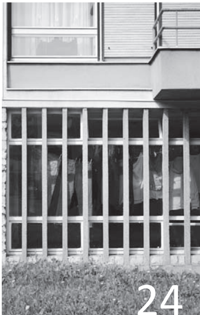
Stanovanjski blok_1965_ Ulica arhitekta Novaka 7
