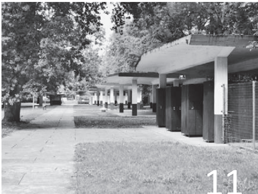
Kopališče in ureditev kompleksa Fazanerija_ 1934–35_ Kopališka ulica 43-45
