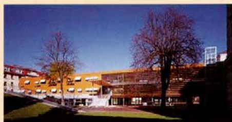
Šola Karl Morre, Gradec, je lesena zgradba, grajena iz nosilnih zidov lameliranega lesa in plošč, stropi so iz širinsko lepljenega lesa.
