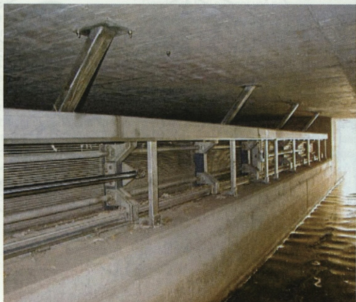
Slika 16 • HST prelivne grablje z avtomatičnim čiščenjem; pogled z notranje ter zunanje strani gabelj
