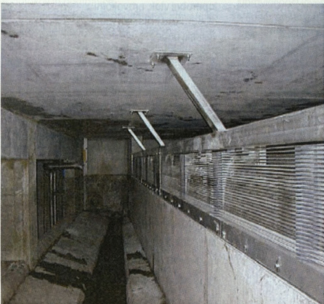
Slika 16 • HST prelivne grablje z avtomatičnim čiščenjem; pogled z notranje ter zunanje strani gabelj
