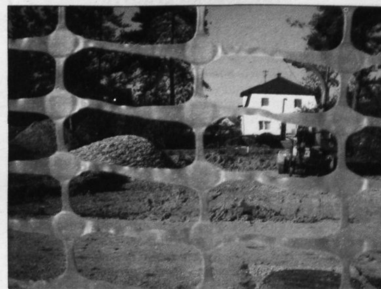
Brežice - Začela se je gradnja križišča in parkirišča pri tržnici Brežice.
