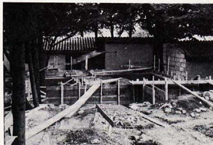
Gradbišče novih počitniških enot v Selcah.
